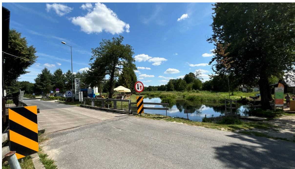
Fot. 9. Zabytkowy most w Bondyrzu
