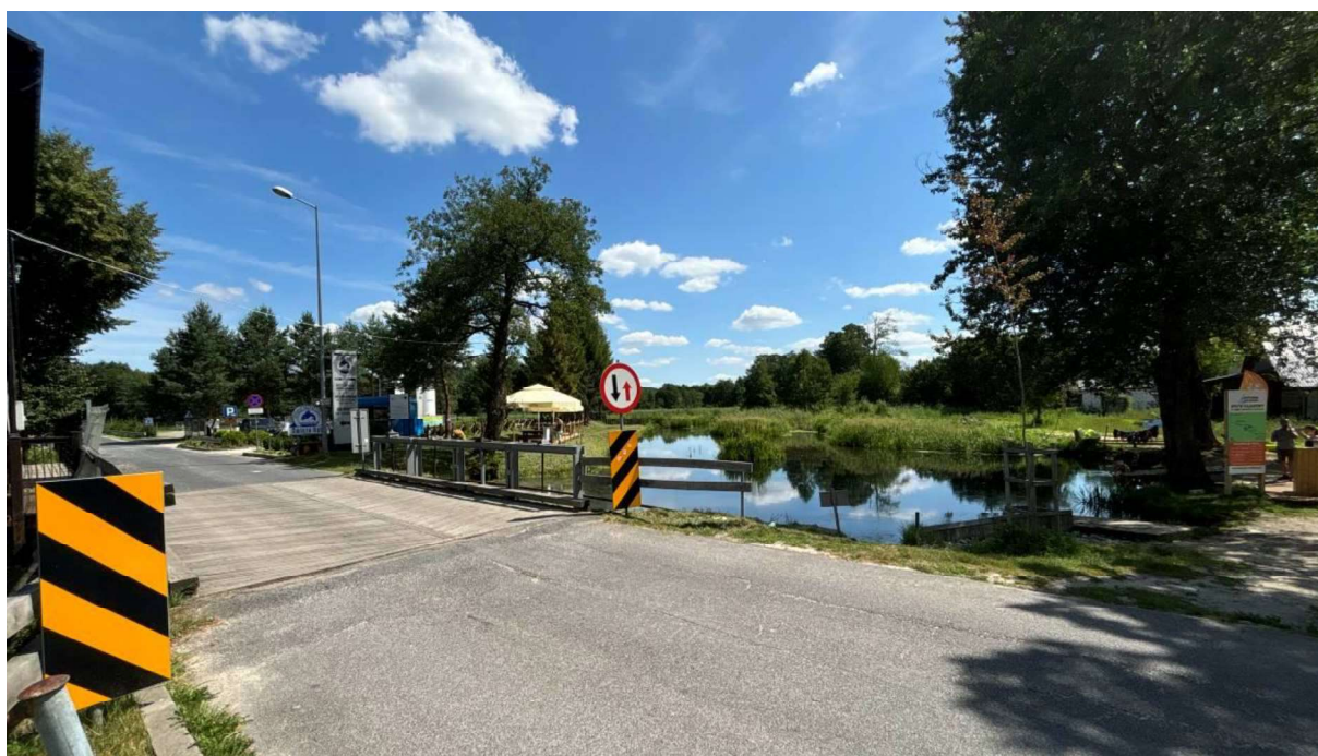
Fot. 9. Zabytkowy most w Bondyrzu
