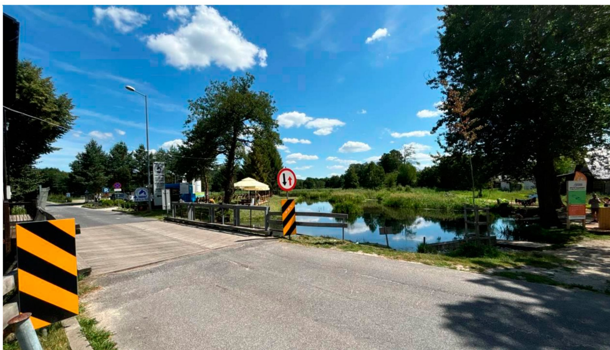
Fot. 9. Zabytkowy most w Bondyrzu
