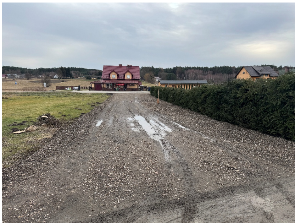
Fot. 13 Droga na działkach 896/2 i 896/1
