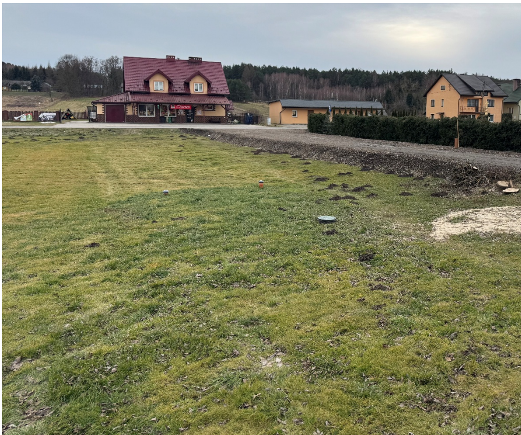
Fot. 11 Oczyszczalnia działka 899
