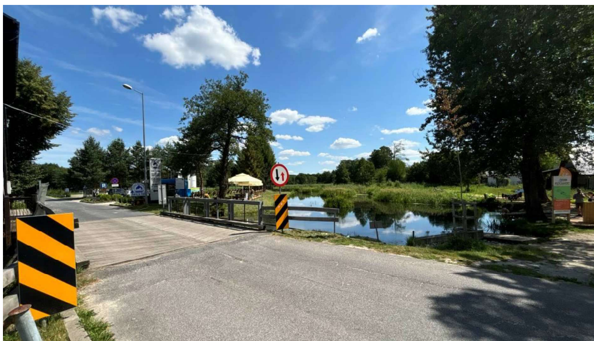
Fot. 9. Zabytkowy most w Bondyrzu
